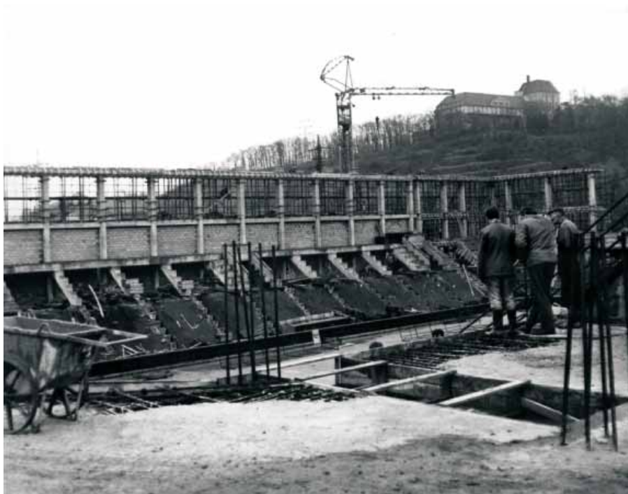
Snímek z výstavby kryté haly, pravděpodobně z r. 1970. V pozadí je vidět obvodový plášť severní tribuny a části východní.
